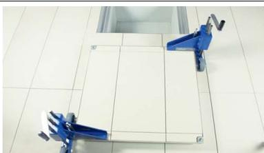
Nun langsam die Abdeckung zur Seite rollen und der Schachtzugang ist geöffnet.
